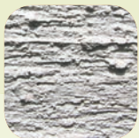
พื้นคอนกรีตหยาบ
