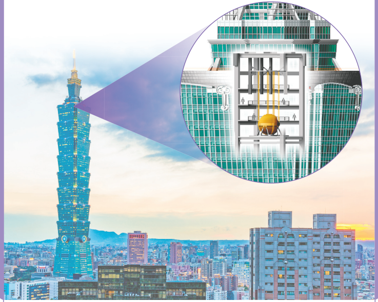
▲ ภาพที่ 1.15 ตึกไทเป 101 ที่มีการติดตั้งลูกตุ้มเพื่อลดการสั่นสะเทือนของตึก ที่มา : คลังภาพ อจท.
